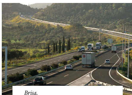
Brisa, Straßennetz, Portugal
