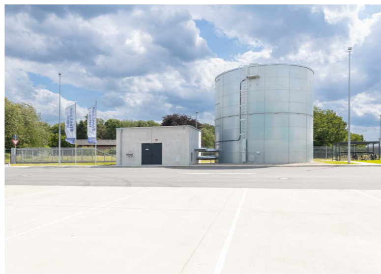
Innovative Speichertechnologie zum Puffern von PV-Strom
