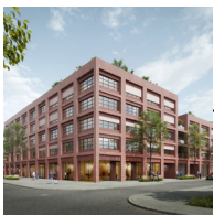
West.Side Office, Bonn Nutzfläche: ca. 35.400 m 2
