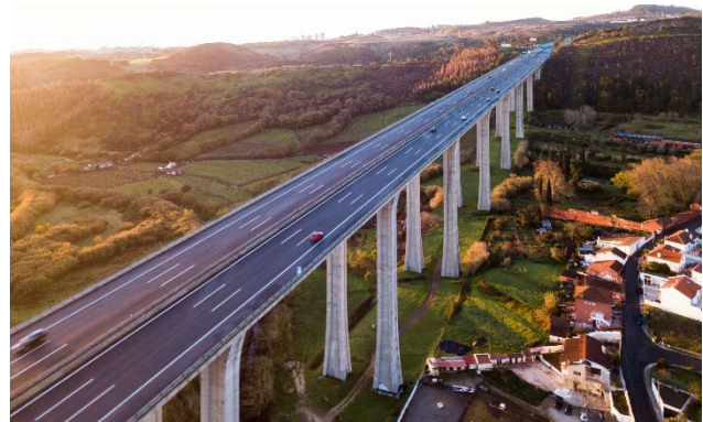
Brisa Concessão Rodoviária's viaduct
