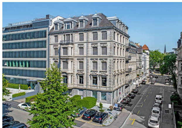
Immagine commerciale a Zurigo (nuovo portafoglio «Immobili commerciali Svizzera»)
